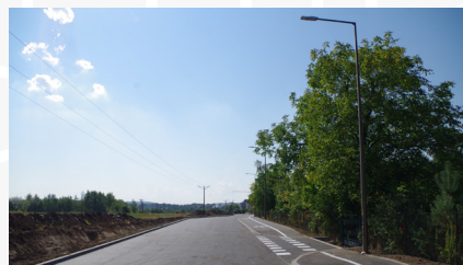
Fot. Uzbrojenie terenu przy WSSE
